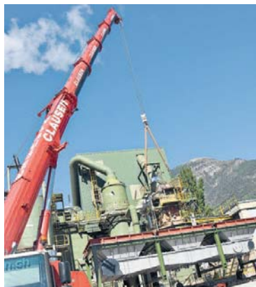
Finish. Montage der neuen Abluftbehandlung. FOTO WB
