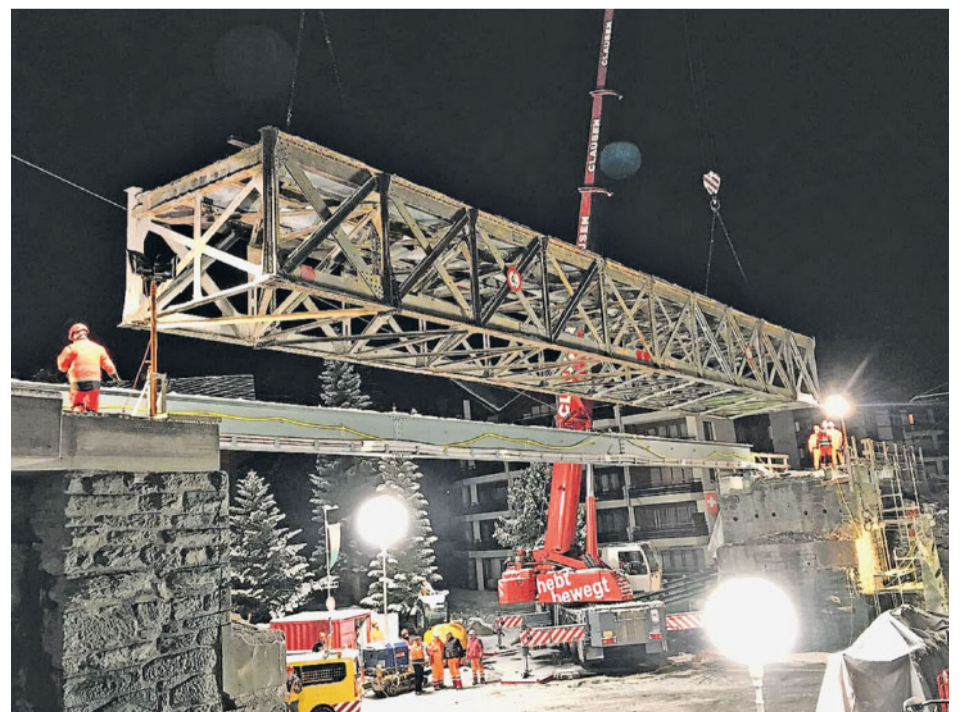
Letzte Züge. Die Getwingbrücke hat nach über 100 Jahren ausgesiedet und wird ersetzt.
