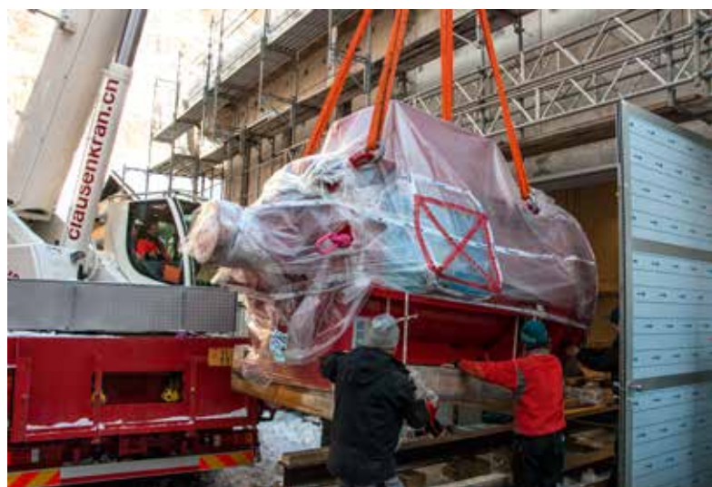
Gleich kann der Generator auf der Verschubbahn abgesetzt werden.
