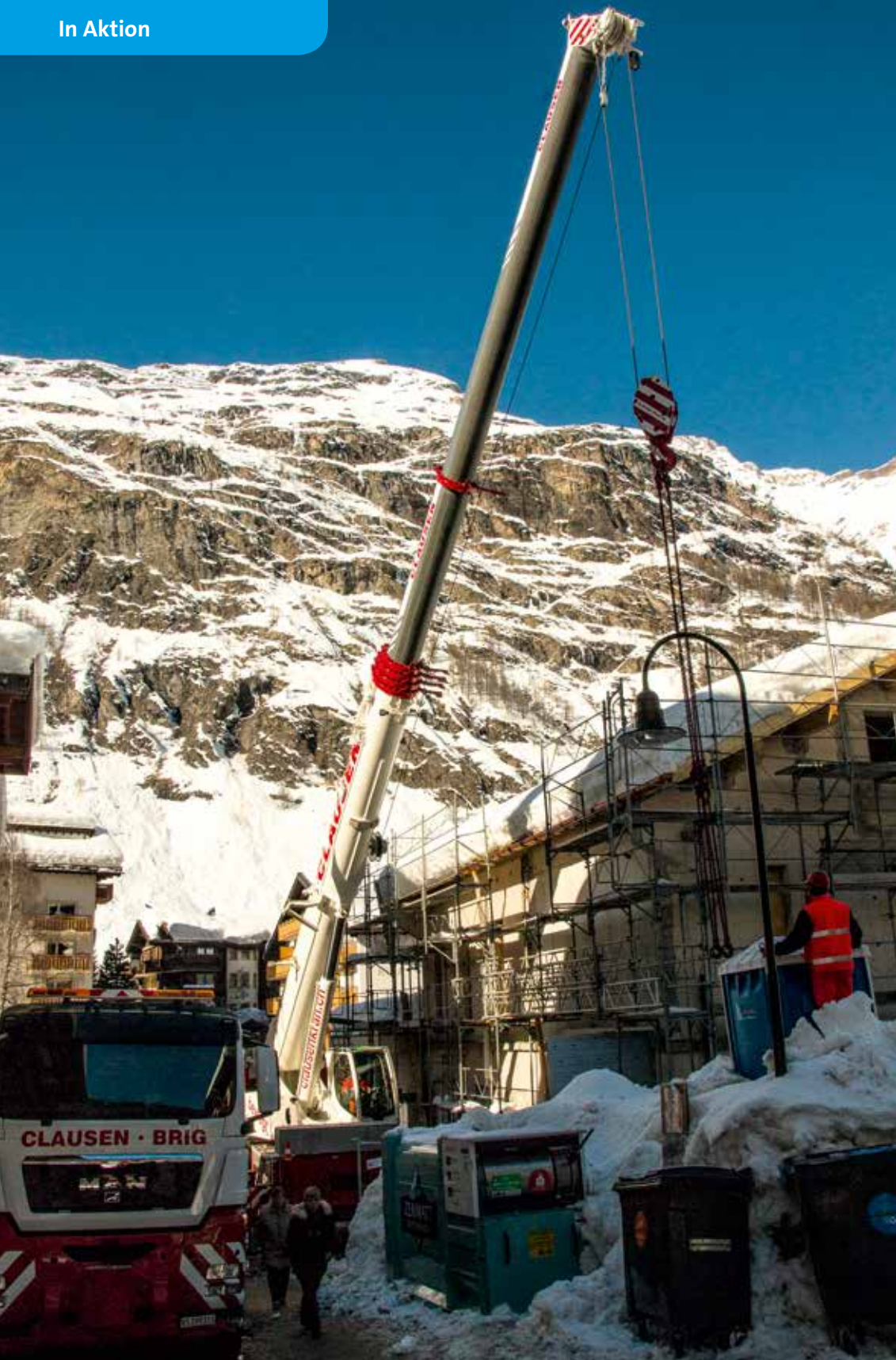
Die Bautoilette wurde für die Kranarbeiten versetzt und muss nun aus dem Schneehaufen geborgen werden.
